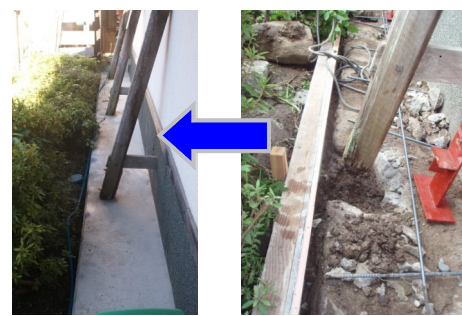
根元が腐って支柱の役目を果たさず。
