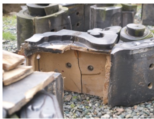
遠目には大丈夫そうに見えた旧鬼瓦（右）ですが、降ろしてみると可也亀裂（左）が入っていました。
