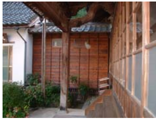
渡り廊下補強修理
